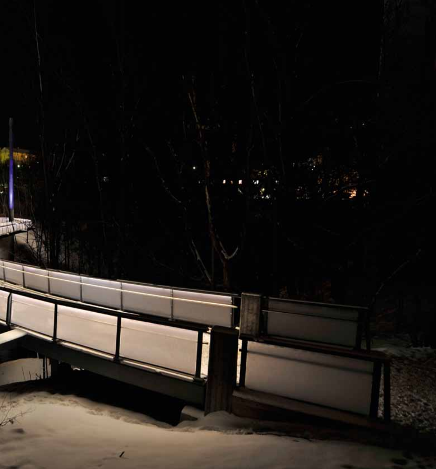
Brua sett fra Sandaker-siden. Brubanen slynger seg mellom trekrone
